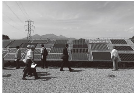
北杜サイト太陽光発電所
